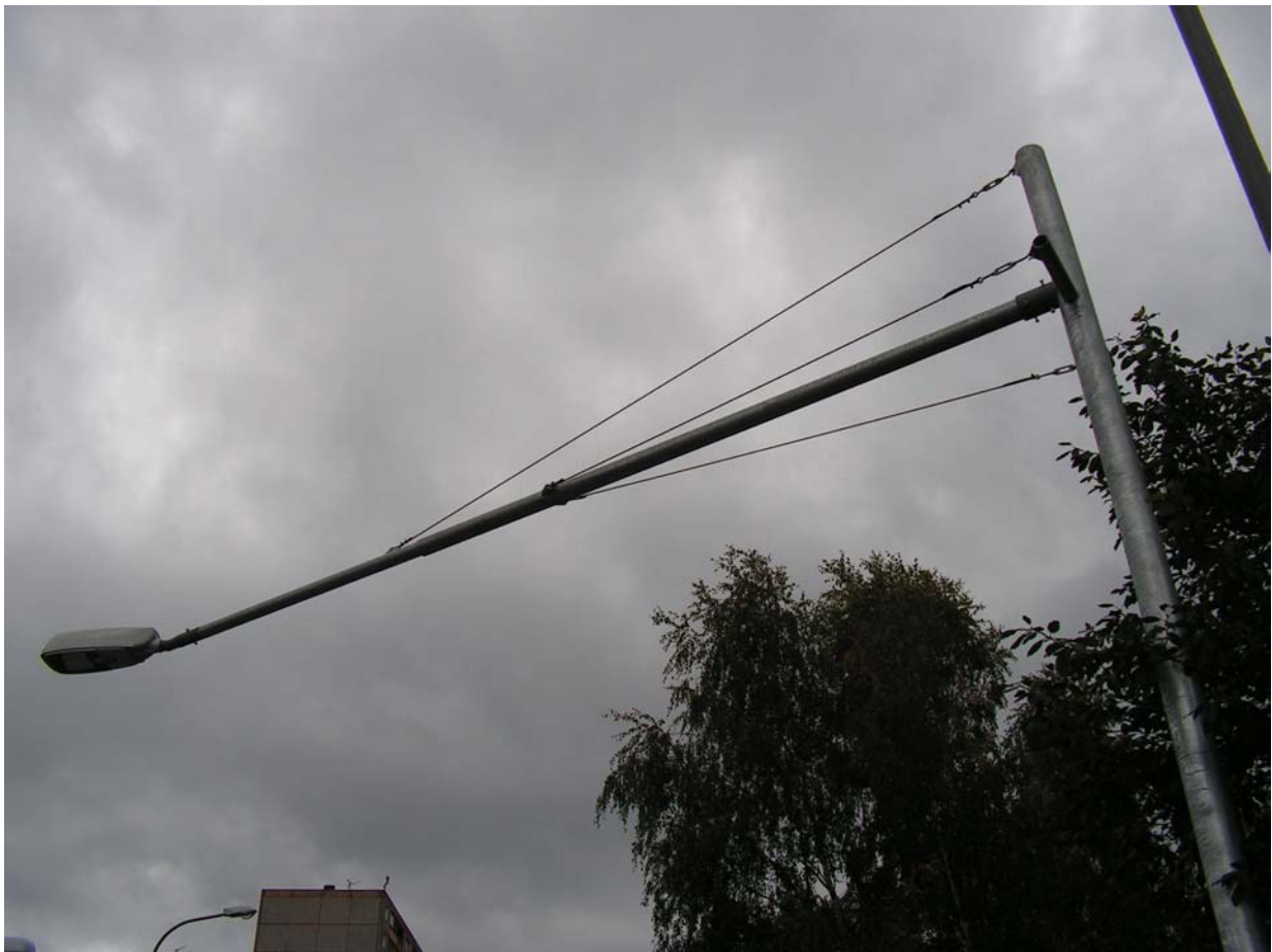
foto 6 detail vyosení svítidla a lanových závěsů
