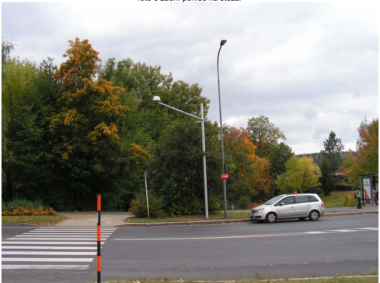
foto 6 srovnání svítidla rovnoběžně s přechodem
